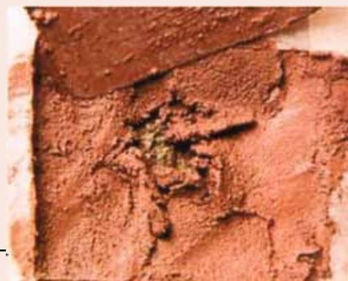
Sulla malta KEIM Restauro Top asciutta sarà possibile affinare la tonalità mediante applicazione dello specifico colore ai silicati per pietre KEIM Restauro-Lasur.
